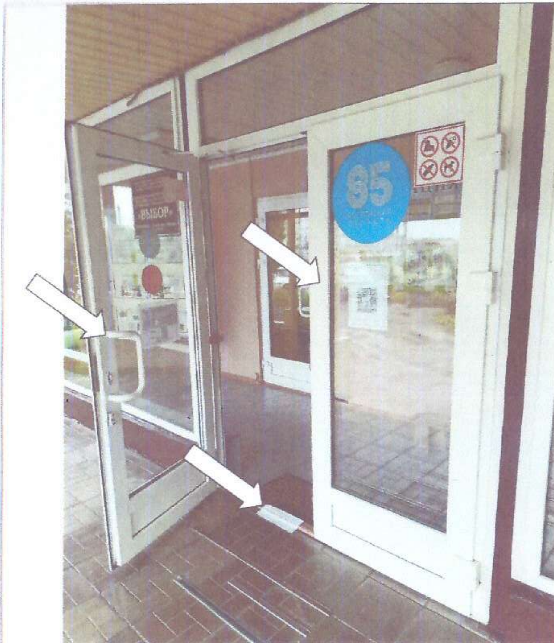
Фото № 3. Дверной проем и дверная ручка контрастно не маркированы. Порог в дверном проеме
