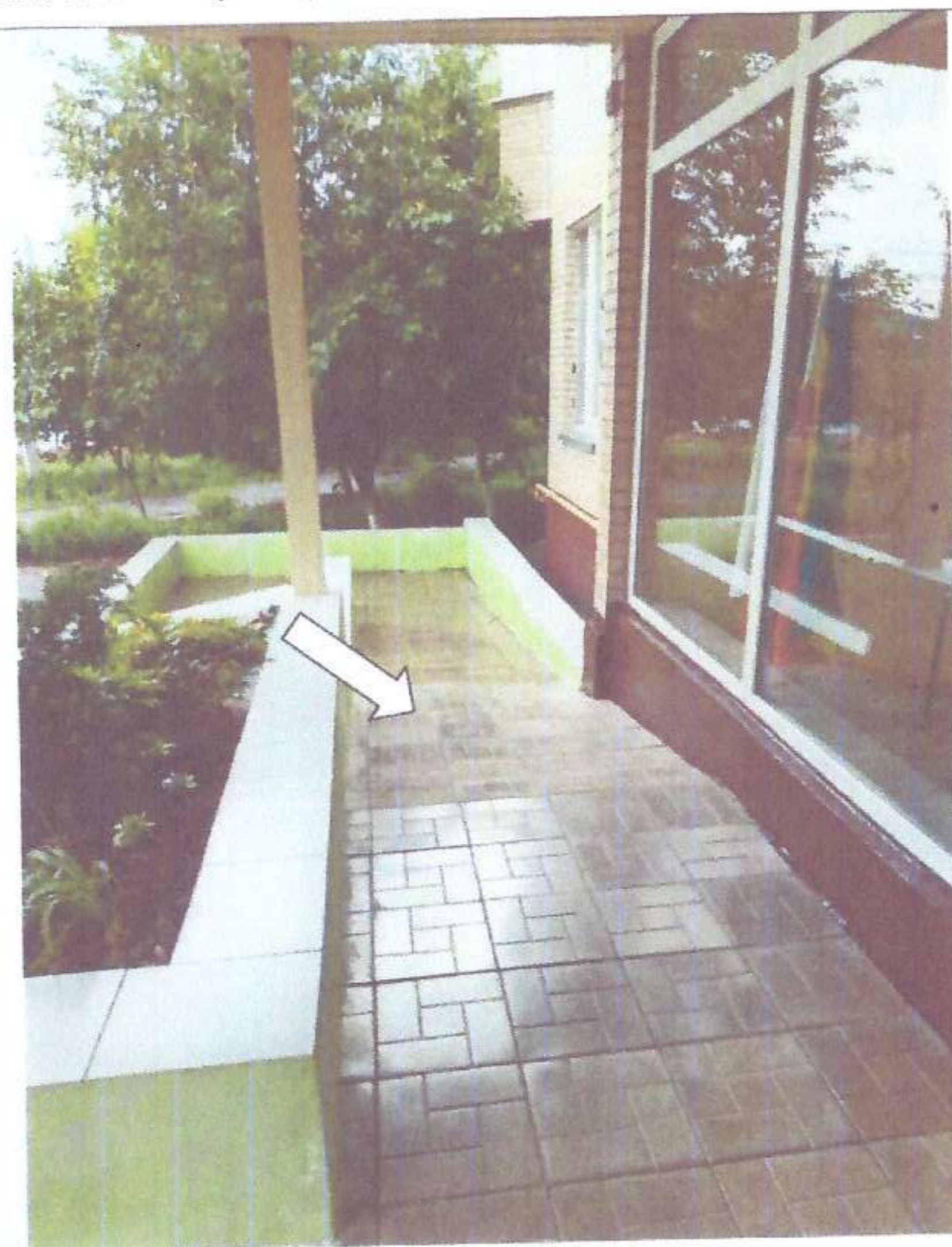
Фото № 2. Нет поручней на пандусе. Верхний марш пандуса имеет разный уклон
