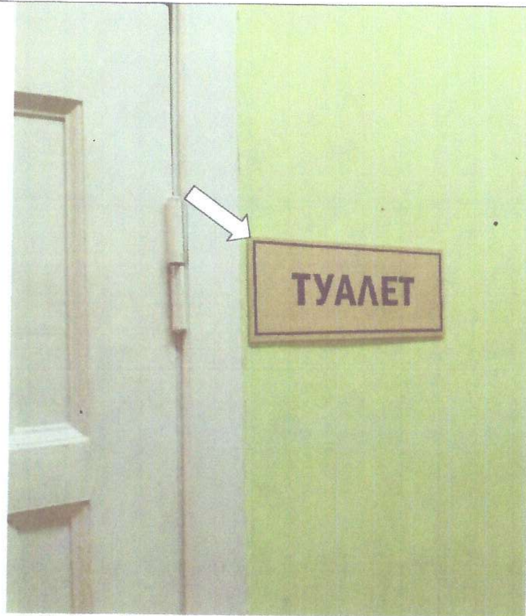
Фото № 12. Дверной проем контрастно не маркирован. Табличка не тактильная.
