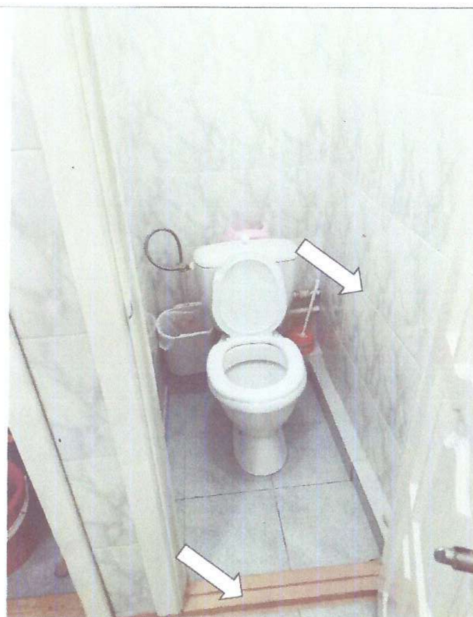
Фото № 10. Нет опорных поручней возле унитаза, порог в дверном проеме
