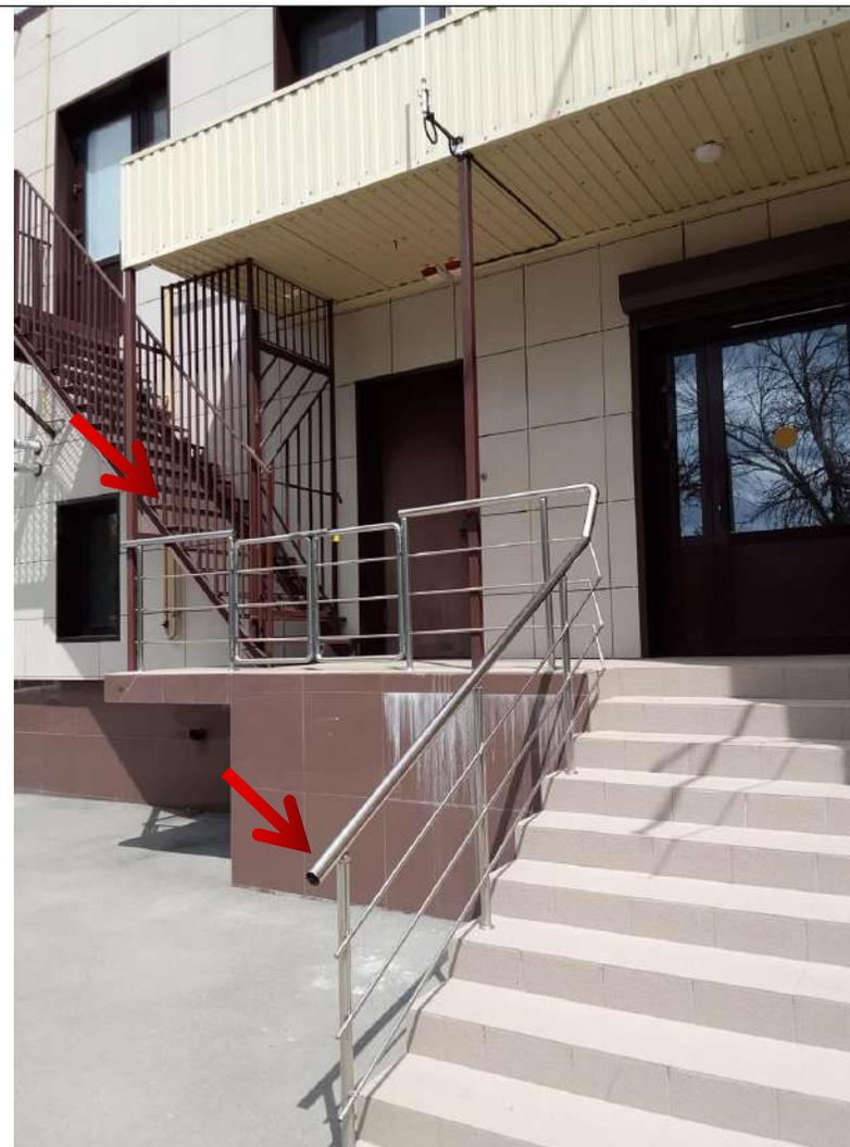
Фото № 6. Поручни с травмирующим завершением. Нет подступенка на лестнице со второго этажа.
